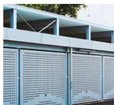
Tief- und Sammelgaragen: Ausführung mit Lüftungsgitter (auch mit Wellengitter).
