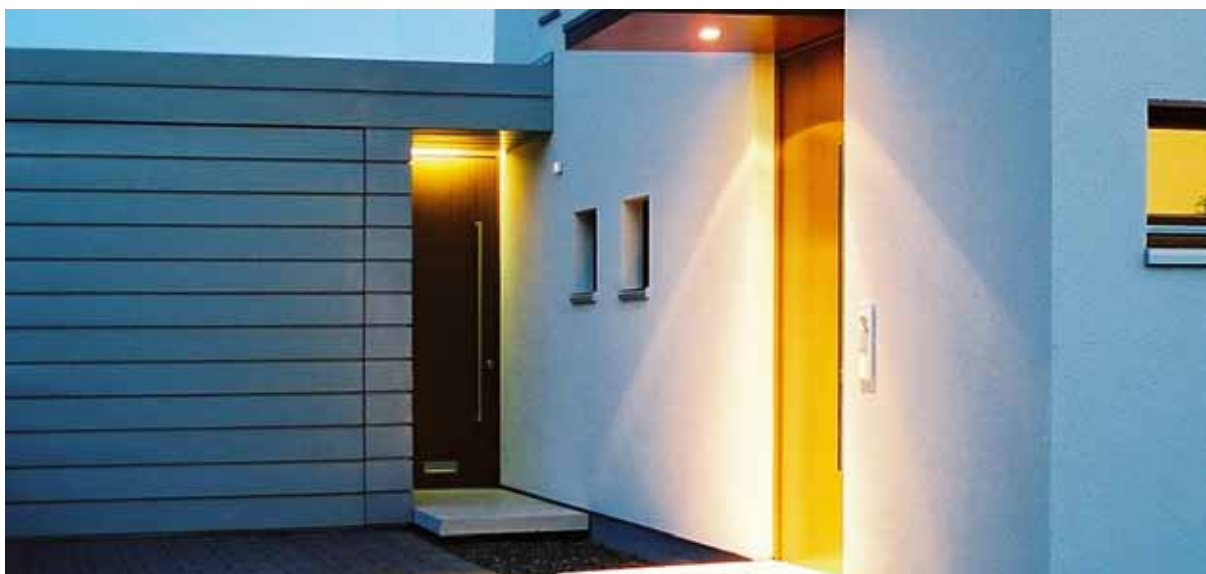
Flächenbündige Sonderlösung mit waagerechten Zinkblechen.
